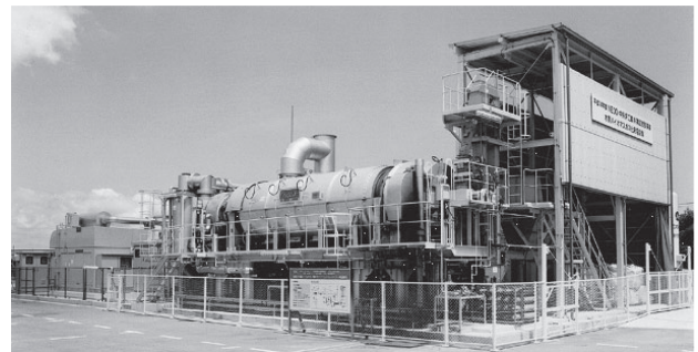
写真3 山口の実証施設
